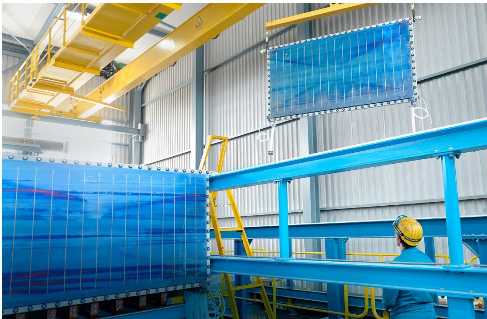
Montage von Elektrolysezellen
